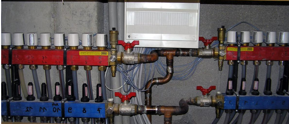
Figur 18 Värmefördelare i ett golvvärmesystem med ställdon och ventiler för rumsreglering.
